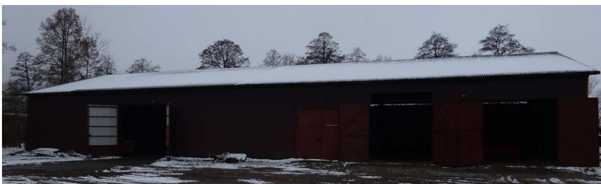
Elewacja frontowa hali.
